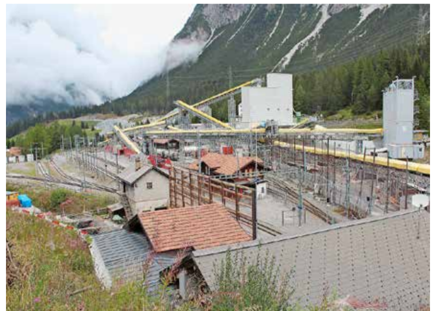
Interessante Einblicke: Die TCS-Regionalgruppe auf Baustellenbesichtigung.
